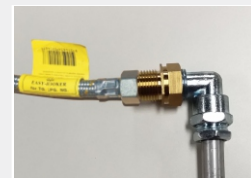
步骤3: 将柔性软管与 单向转接头连接
